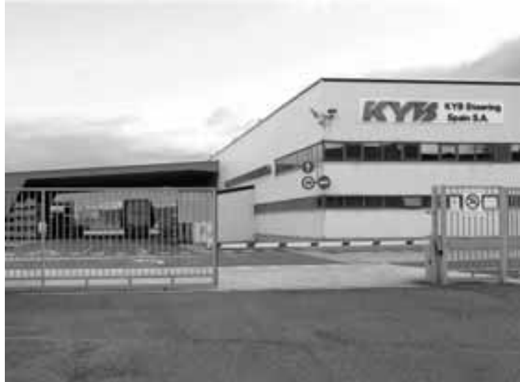
Acceso principal a la planta de KSS en Orkoien.
